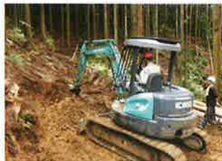
作業道開設中
